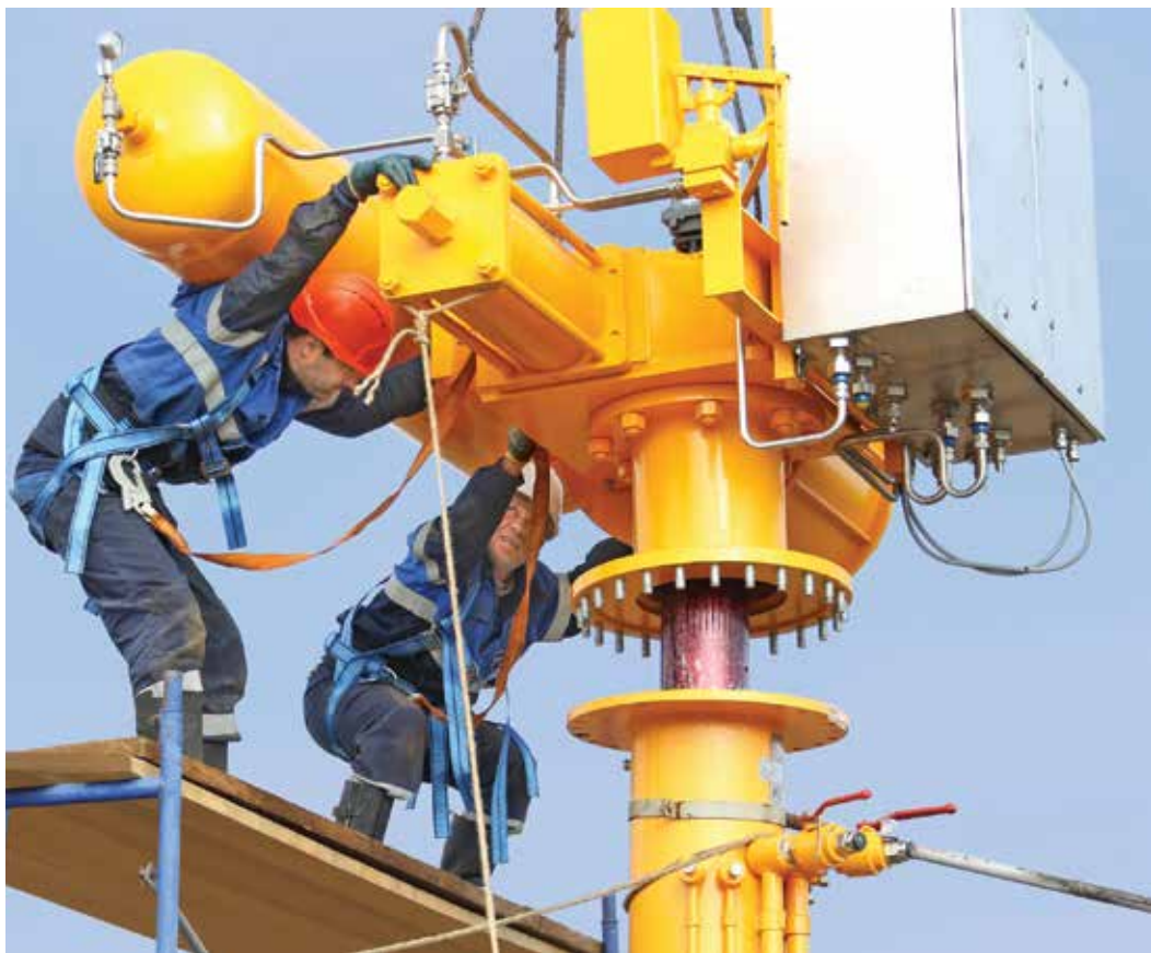
Ювелирная работа с многотонным оборудованием
