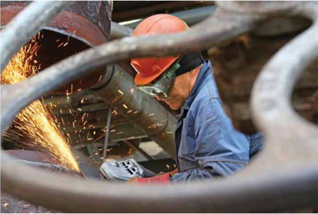
Идет обработка кромок трубопровода
