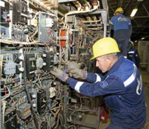
На электроподстанции ведется замена масляных выключателей на вакуумные
