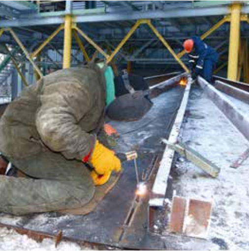
Этой крышей накроют цилиндр резервуара
