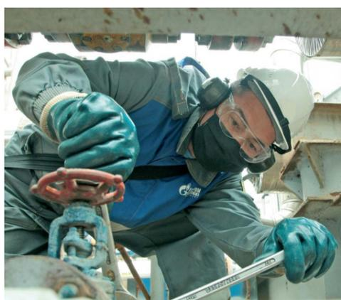
Машинист технологических компрессоров Ринат Салимьянов демонтирует запорную арматуру
