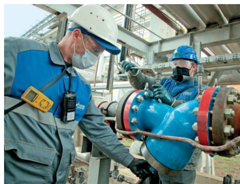
Мастер по подготовке газа Вадим Исаев и машинист технологических компрессоров Виктор Чернышов производят сборку датчиков перепада давления на сетчатом фильтре
