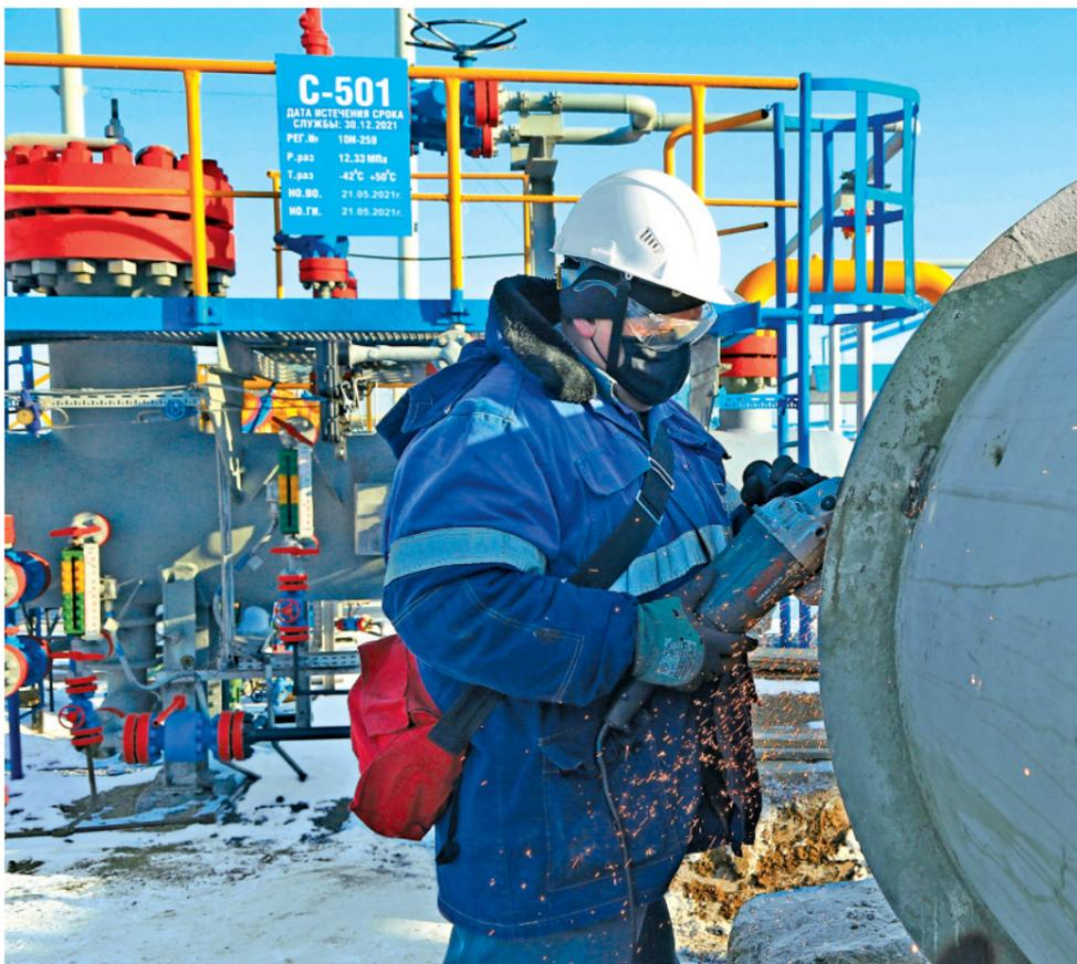
Слесарь по ремонту технологических установок Александр Бахтин проводит подготовку поверхности для разметки места реза будущего сварного соединения
