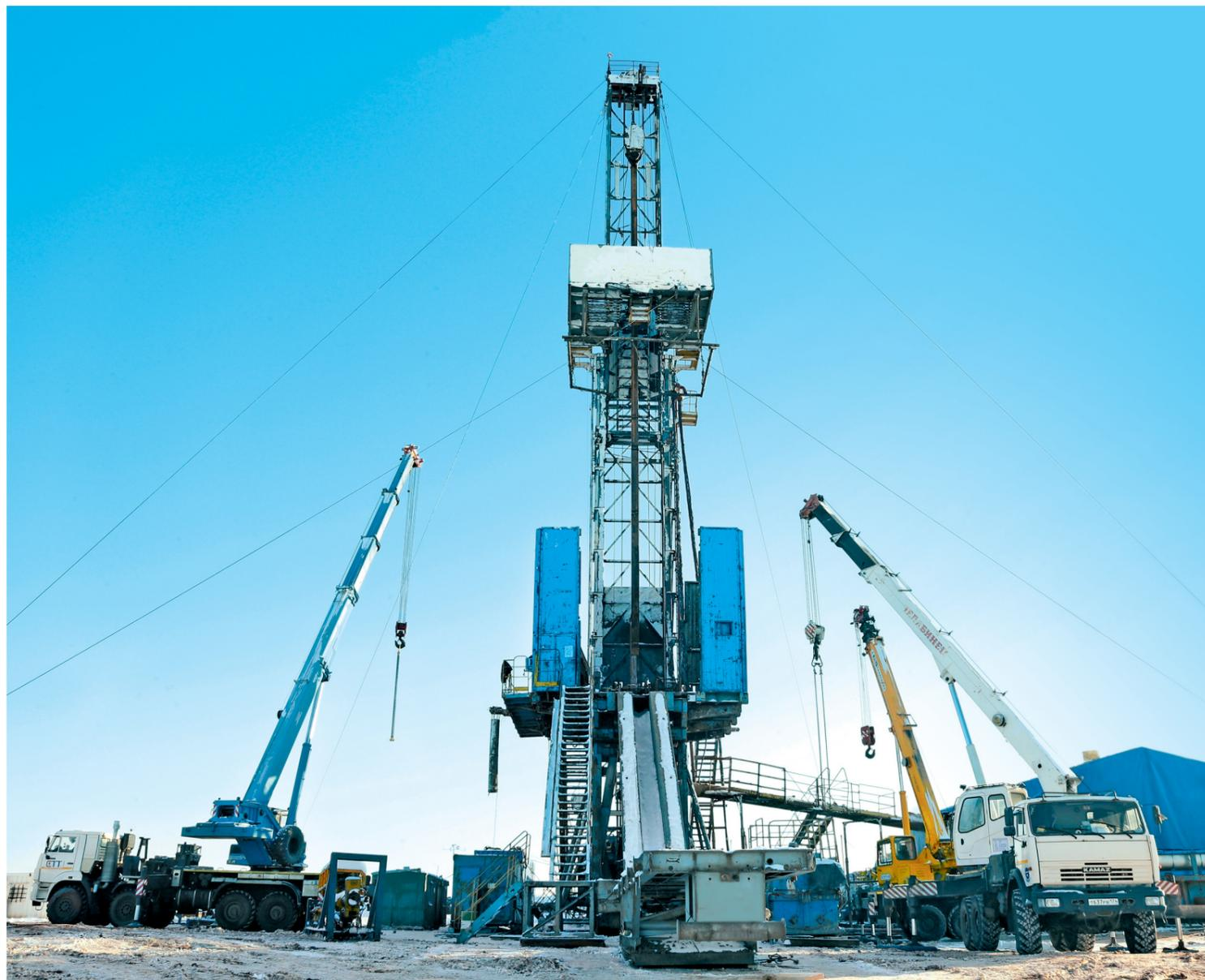
Монтаж бурового оборудования на месте строительства скважины № 14071
