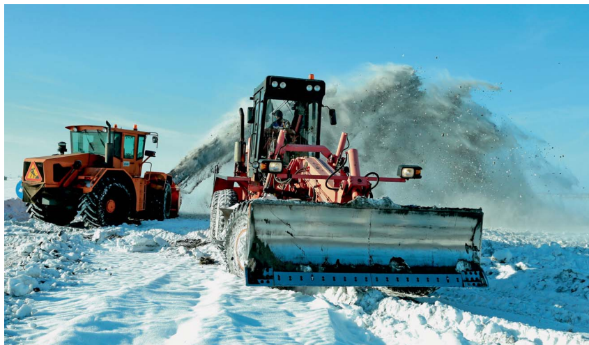
Проводится расчистка подъездных путей и площадки для автотранспорта
