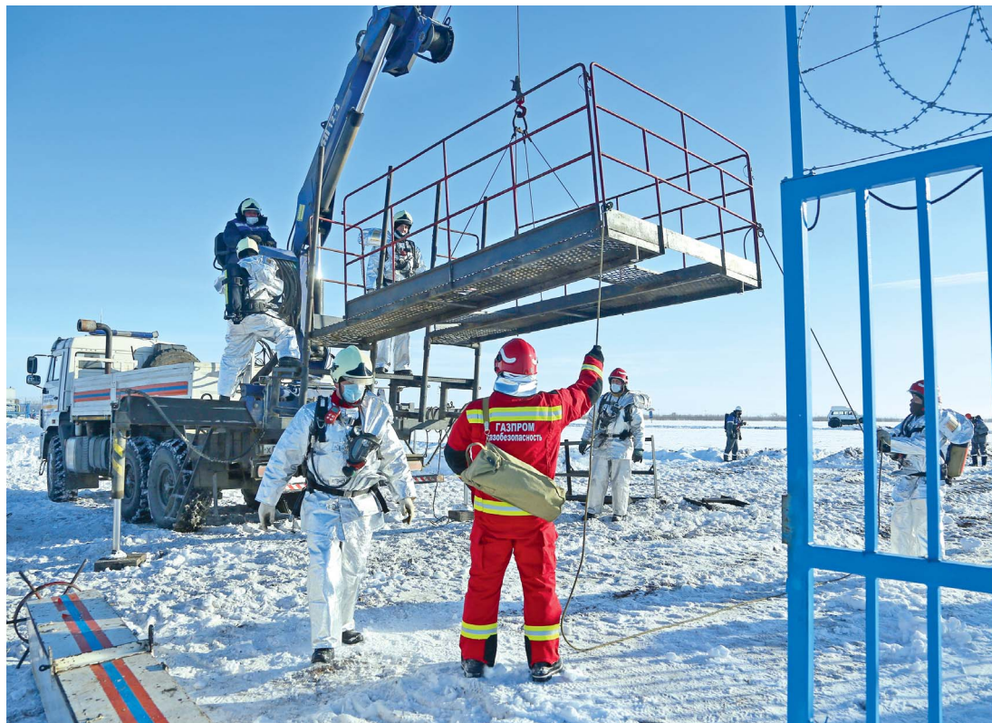
Работники ОВЧ ООО «Газпром газобезопасность» выполняют установку мостков для аварийных работ на устье скважины
