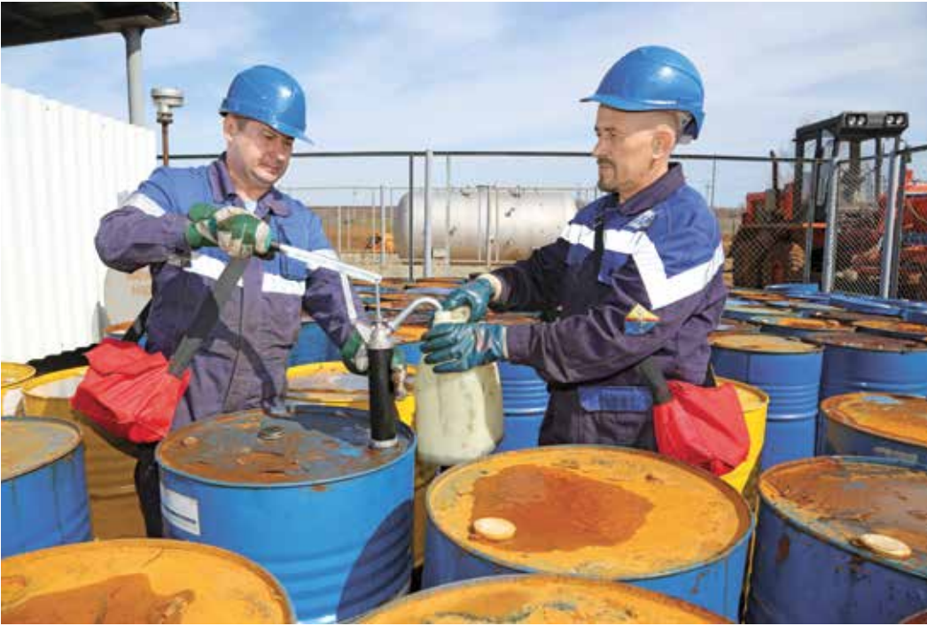
Слесари по ремонту технологических установок газопромыслового управления Леонид Черняков (слева) и Евгений Востров ведут отбор масла для замены на насосе по перекачке водно-метанольной смеси. На заднем плане — емкость для хранения стабильного конденсата
