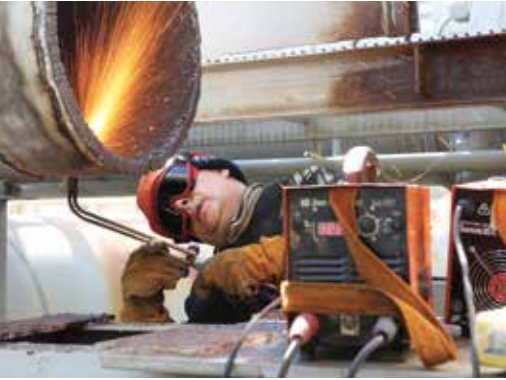
Идет подготовка к монтажу нового крана
