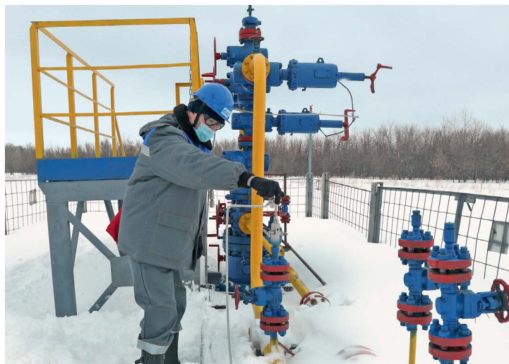
Оператор по добыче нефти и газа Николай Учаев проверяет герметичность системы автоматики безопасности скважины
