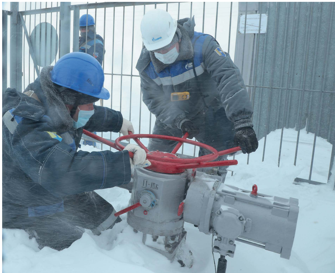
Трубопроводчик линейный Сергей Кузьмин и мастер линейно-эксплуатационной службы № 1 Евгений Далужев проверяют работоспособность запорной арматуры в ручном режиме
