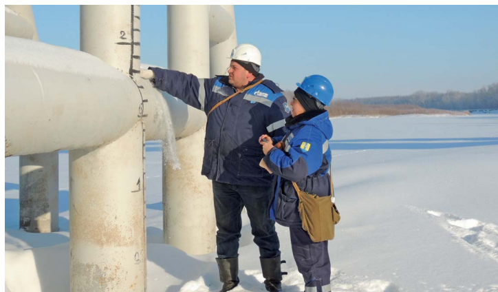
Проверка технического состояния опор воздушных переходов трубопроводов — один из пунктов подготовки объектов к весенне-наводковому периоду
