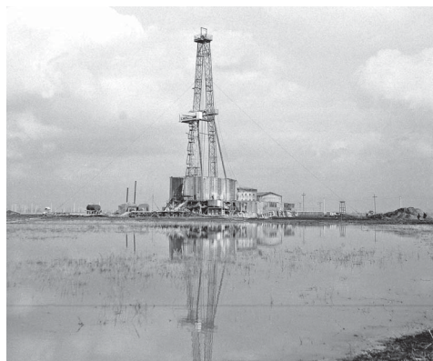
Буровая на Оренбургском нефтегазоконденсатном месторождении
