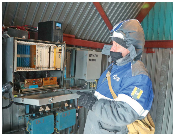
Слесарь по КИПиА Виктор Головнев контролирует прохождение сигнала при дистанционной проверке запорной арматуры
