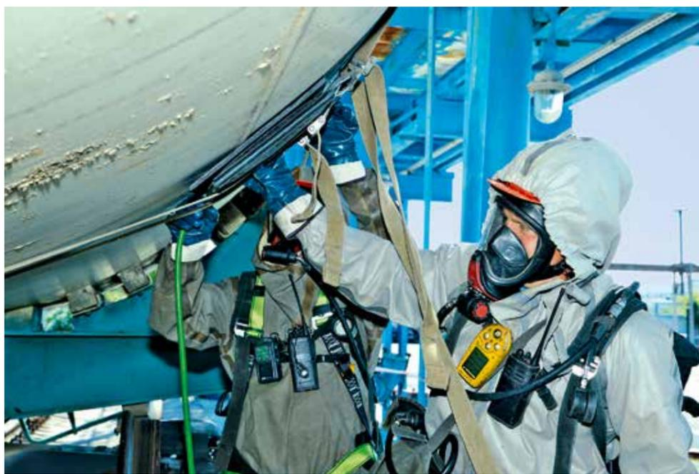
Идет установка магнитного пластыря
