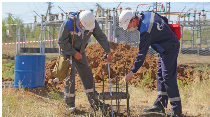
Владислав Кейль и Андрей Гранкин проверяют глубину скважины под сваю
