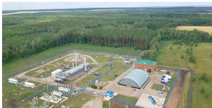
Производственная база и перекачивающая насосная станция ЛЭС-3 Октябрьского ЛПУ
