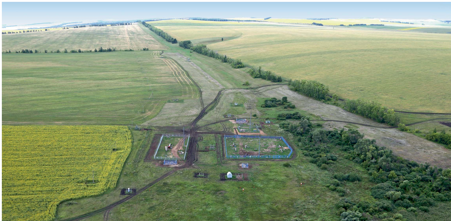
Узел приема-запуска очистных устройств на 136,8 км конденсатопроводов Оренбург — Салават — Уфа I—IV нитки
