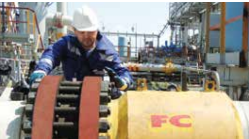
Ремонт газоперекачивающего агрегата № 5 завершен
