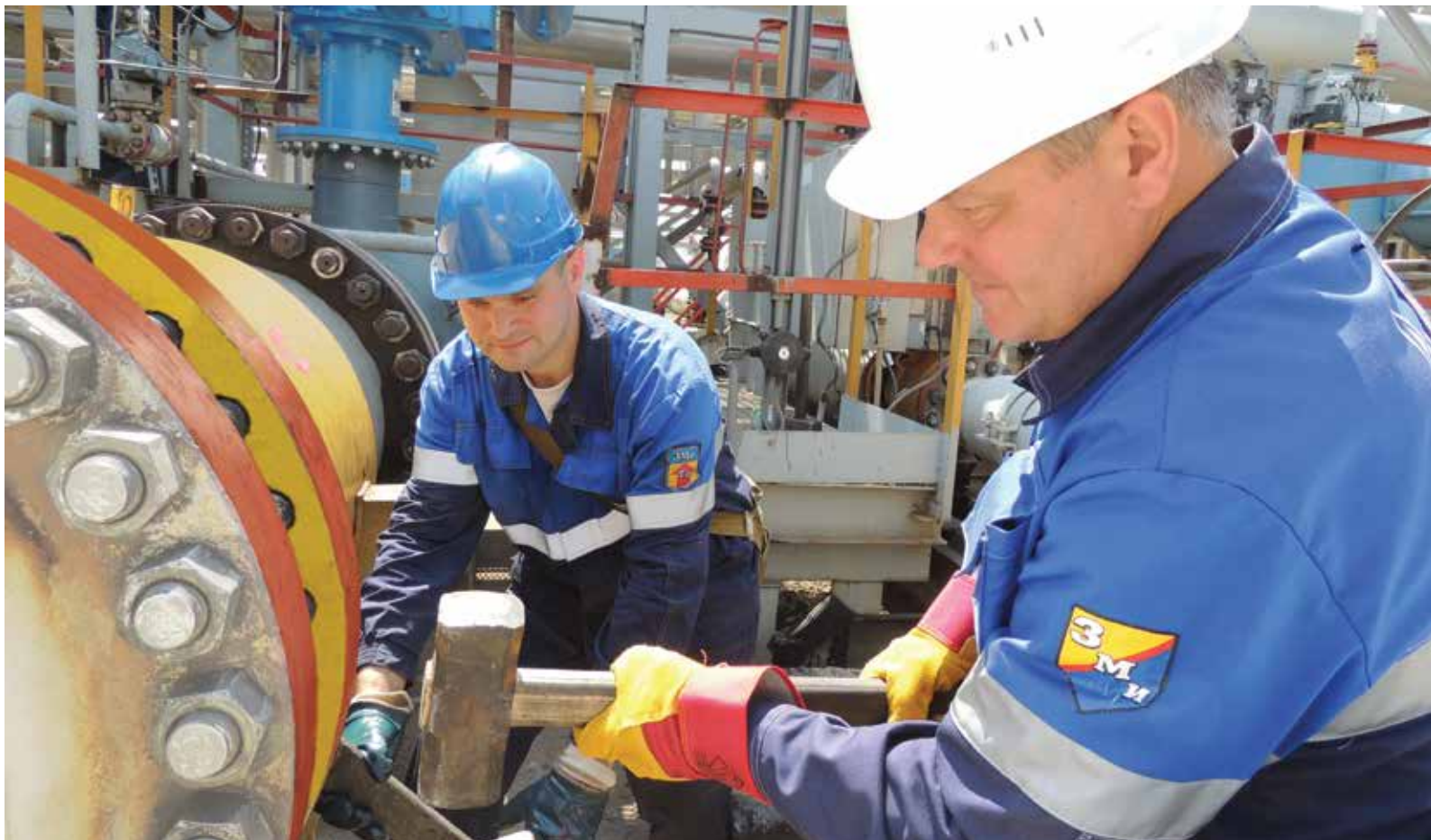
Монтаж обратного клапана на модульной обвязке
