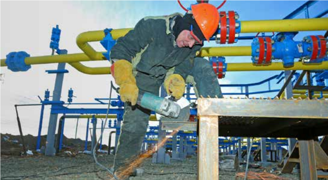
Подрядчики завершают монтаж сборно-распределительной гребенки № 5
