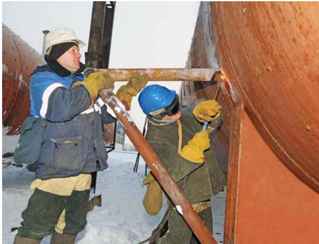
Сварщик Руслан Давлетбердин и газорезчик Радик Шарипов готовят емкость к предстоящему ремонту
