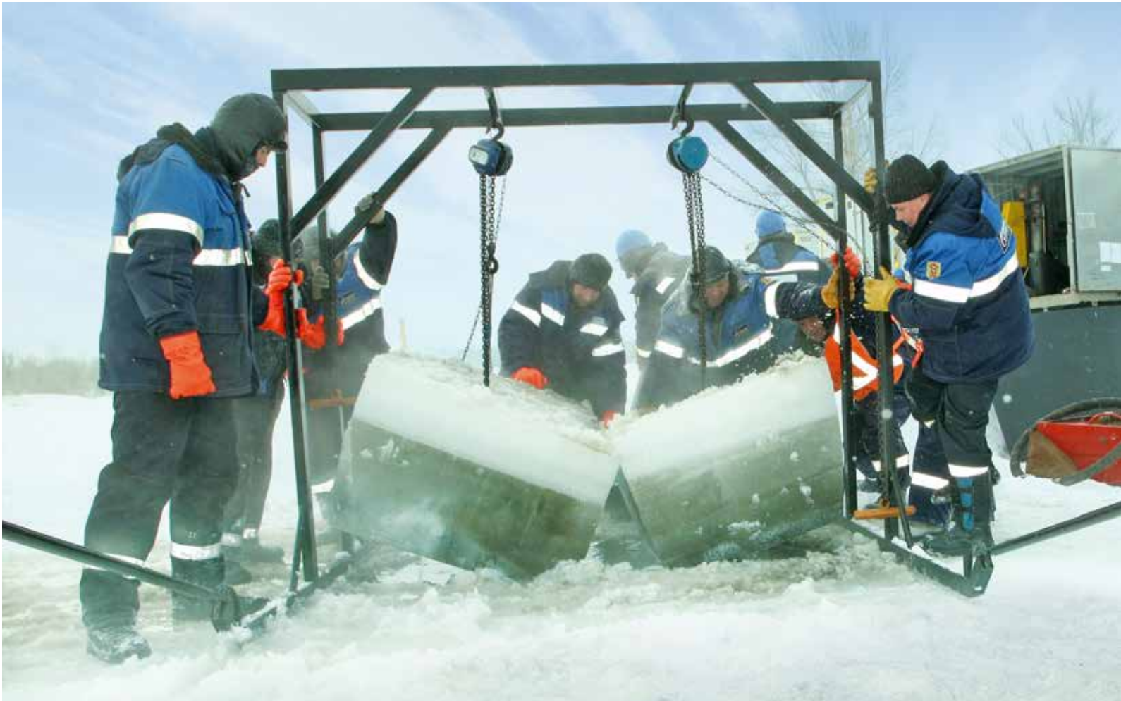
Работники Октябрьского линейно-производственного управления прорубили майну для сбора нефтепродукта с водной поверхности. Чтобы достать из нее глыбы льда толщиной более полуметра, без помощи специального оборудования не обойтись
