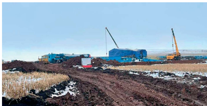
Подготовка к началу бурения
