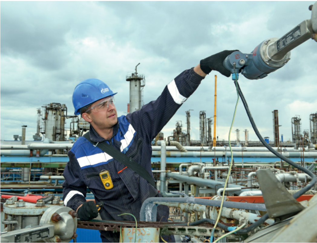
Приборист Александр Воробьев подключает буйковый уровнемер
