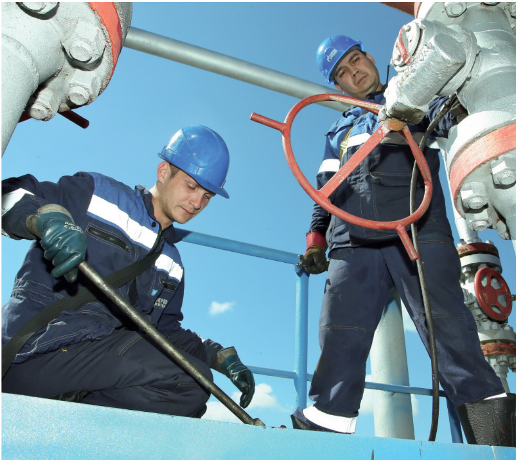
Операторы по добыче нефти и газа Денис Чернышов и Алик Байгулов закачивают герметик в уплотнение шарового крана на блоке входных ниток
