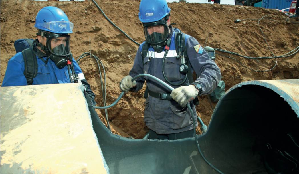
Трубопроводчики линейные Фидан Хамидуллин (справа) и Антон Лопин устанавливают в трубопровод герметизирующее устройство
