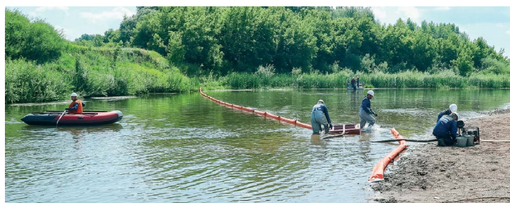
Установка боновых заграждений
