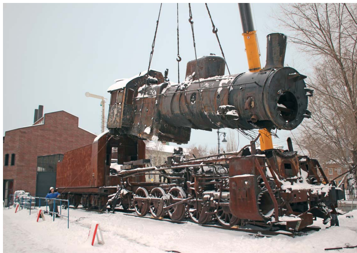
Завершающий этап монтажа
