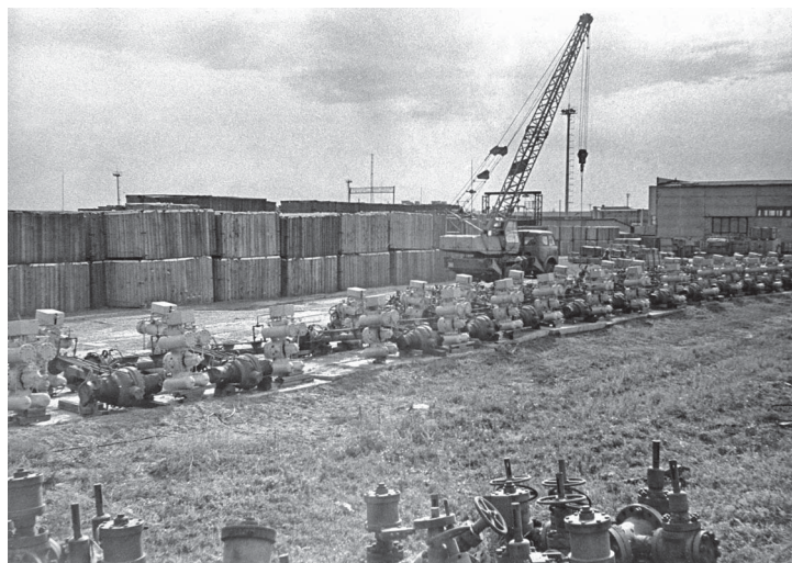
Площадка хранения запорной арматуры
