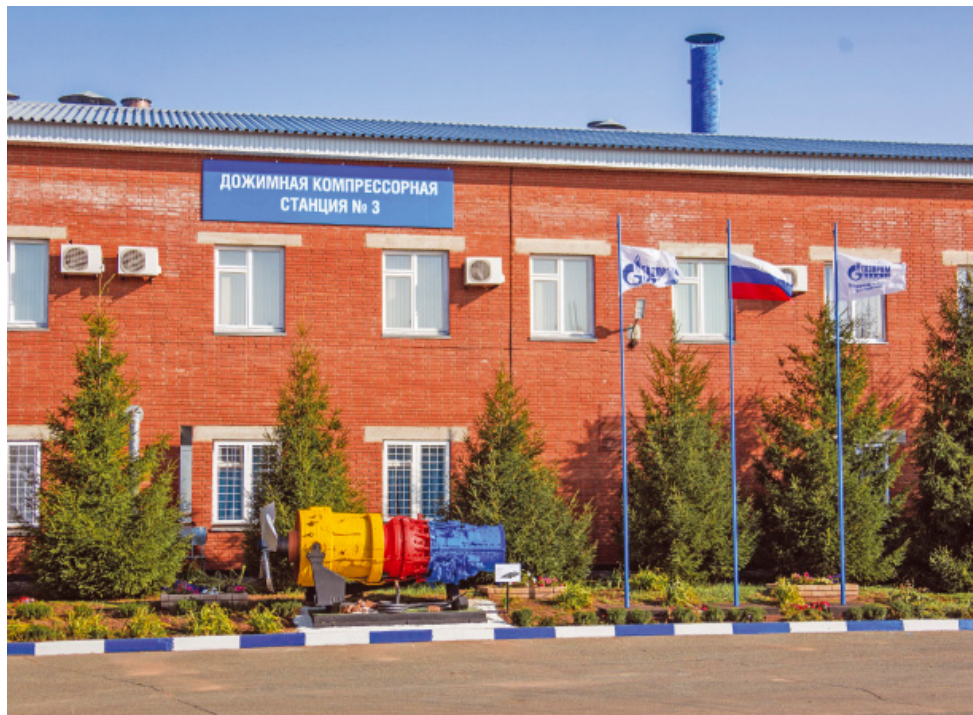
Дожимная компрессорная станция № 3 газопромыслового управления
