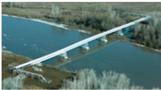
Воздушные переходы трубопроводов контролируют работники УЭСП
