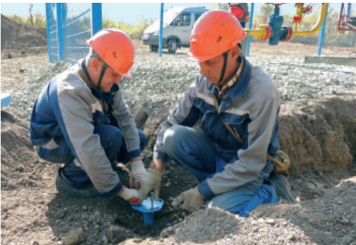
Завершается монтаж нового ограждения скважины № 15032
