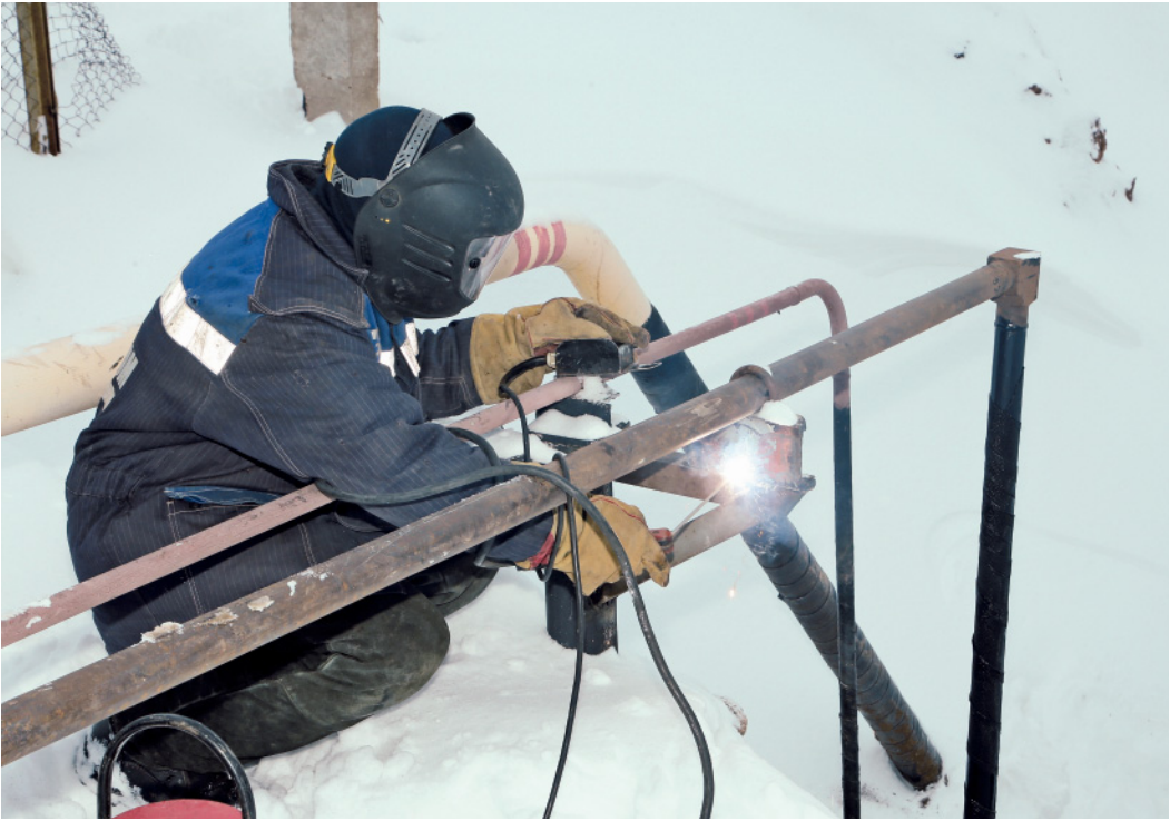
Электросварщик ручной дуговой сварки Спартак Мишкин выполняет работу по монтажу опор трубопроводов
