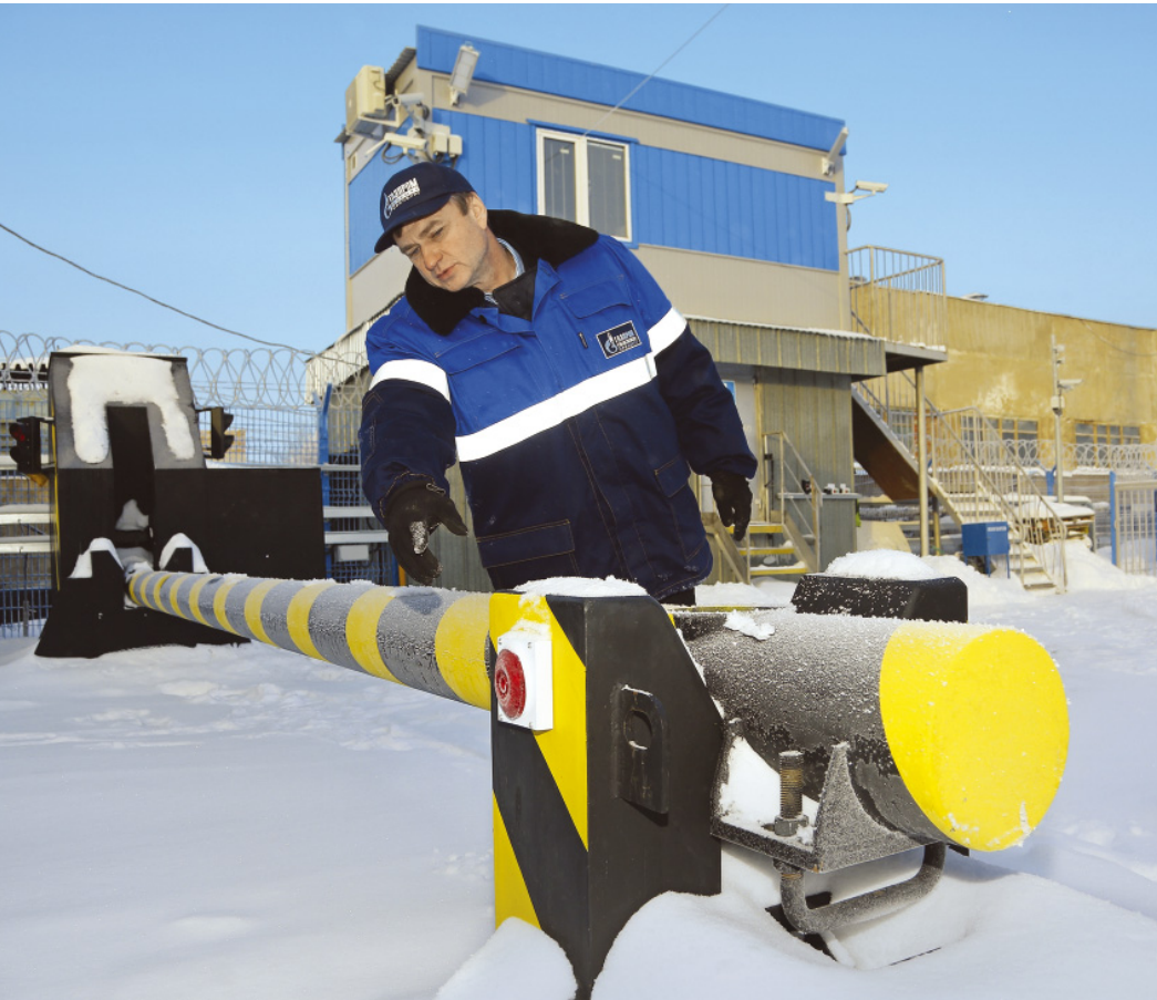
Игорь Андреев демонстрирует элементы системы инженерно-технических средств защиты
