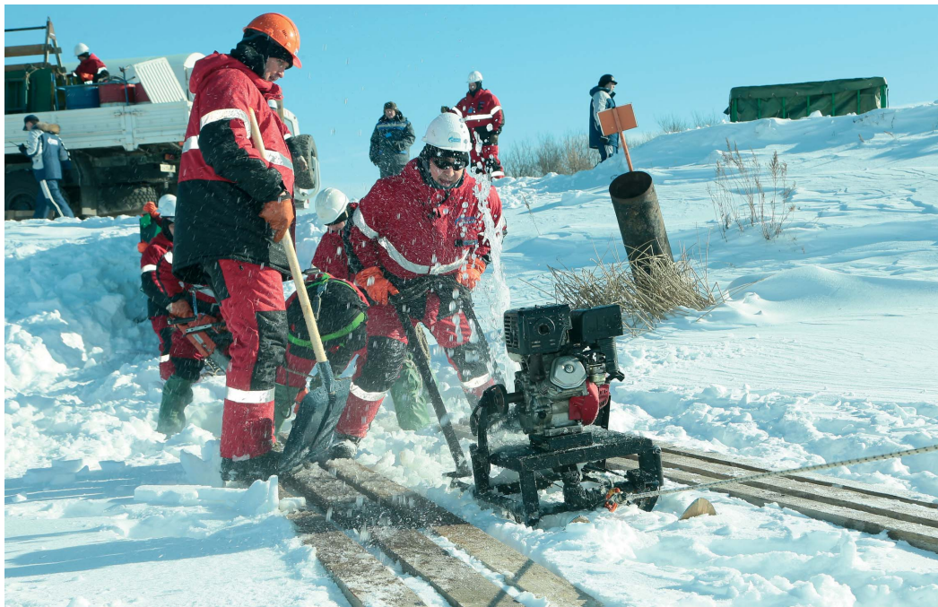
Персонал группы оперативного реагирования ВЧ разрезает лед, чтобы поставить щиты заграждения
