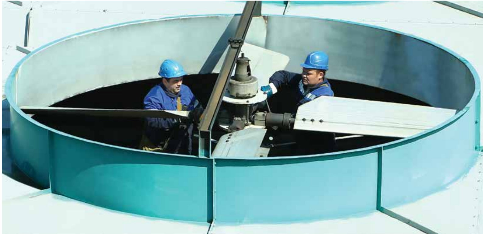
Николай Салеев и Андрей Белкин проводят регулировку лопастей вентилятора аппарата воздушного охлаждения
