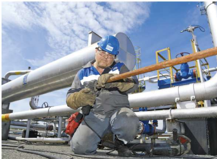
Слесарь Илдар Мавляков ведет монтажные работы по подключению второй ветки очищенного газа
