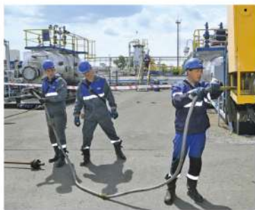
Операторы по добыче нефти и газа Сергей Межуев, Денис Чернышов и машинист ППУ Виктор Вязников подключают газ к горелочному устройству
