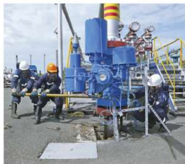
Газоспасатели устанавливают заглушки на клапане-отсекателе
