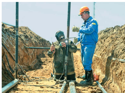
Ведутся сварочно-монтажные работы по подключению внутрипромысловых трубопроводов
