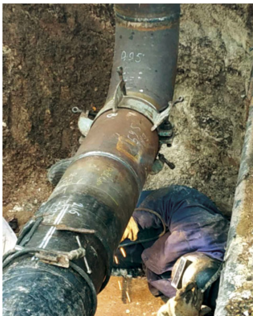
Ремонтные работы на этанопроводе Оренбург — Казань
