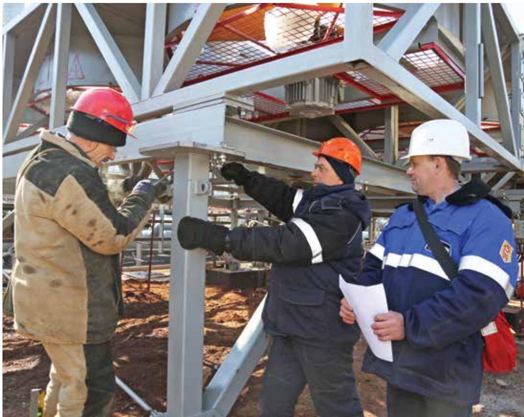
Под контролем механика установки № 2 Виктора Перелетова (справа) ведется монтаж блока вентиляторов аппарата воздушного охлаждения
