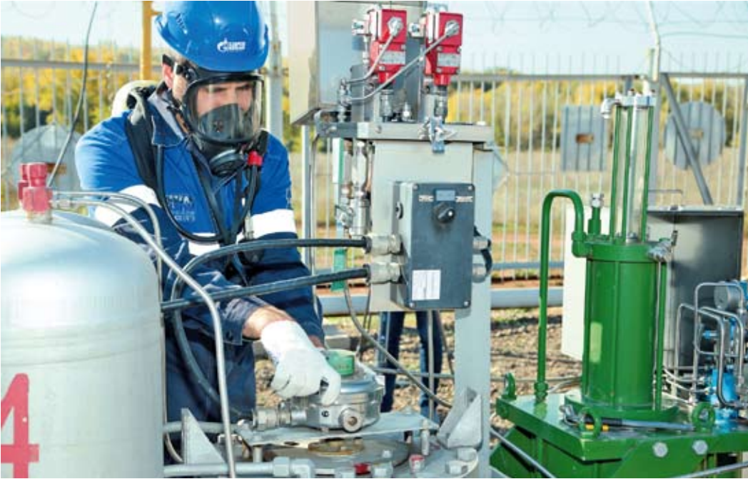
Слесарь контрольно-измерительных приборов и автоматики Павел Теряев настраивает концевые выключатели
