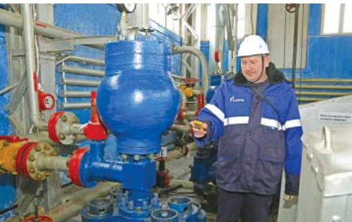
Алексей Денякин с помощью газоанализатора контролирует насосное оборудование на наличие микроутечек
