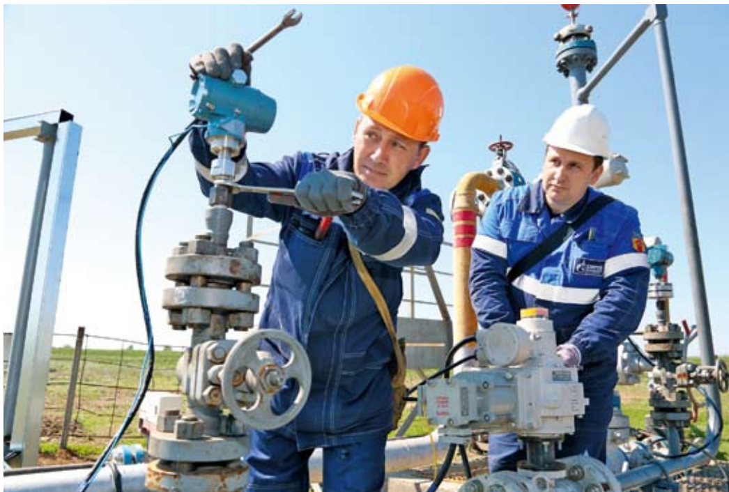
Оператор по добыче нефти, газа и конденсата Виталий Колбасов и мастер Андрей Антипин ведут монтаж электроприводной задвижки
